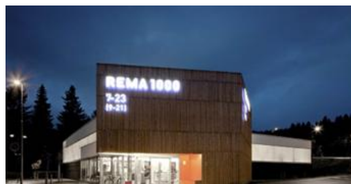
REMA1000 Kroppanmarka, et av de første dagligvarebutikkene som ble bygd med system for kulde- og varmeproduksjon som bruker CO 2 som kuldemedium. Foto: REMA1000 Norge
