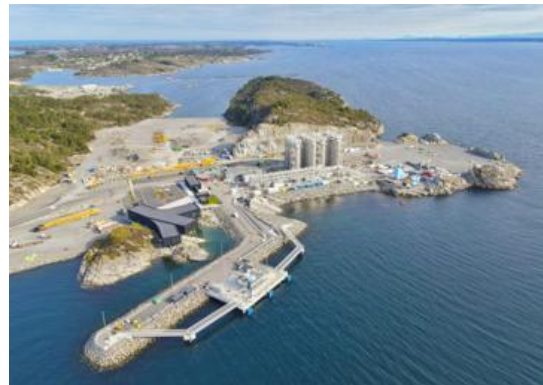
Northern Lights CO 2 terminal i Øygarden som er operativt fra sommeren 2025. CO 2 losses fra skip og injiseres gjennom rør til permanent lager. Foto: Northern Lights Joint Venture, juni 2023.
